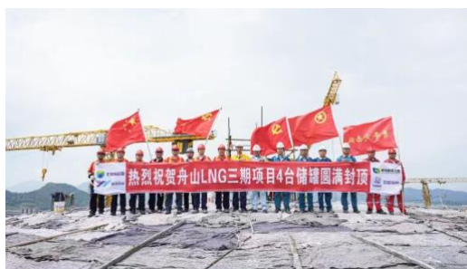
舟山接收站 4 台新增储罐圆满封顶
